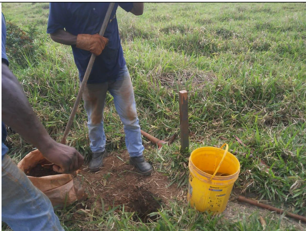
Imagem 15 - ST-101 em execução
