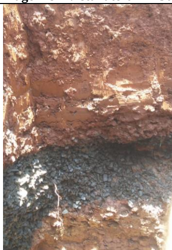
Imagem 11 - Subleito e dreno PI-301
