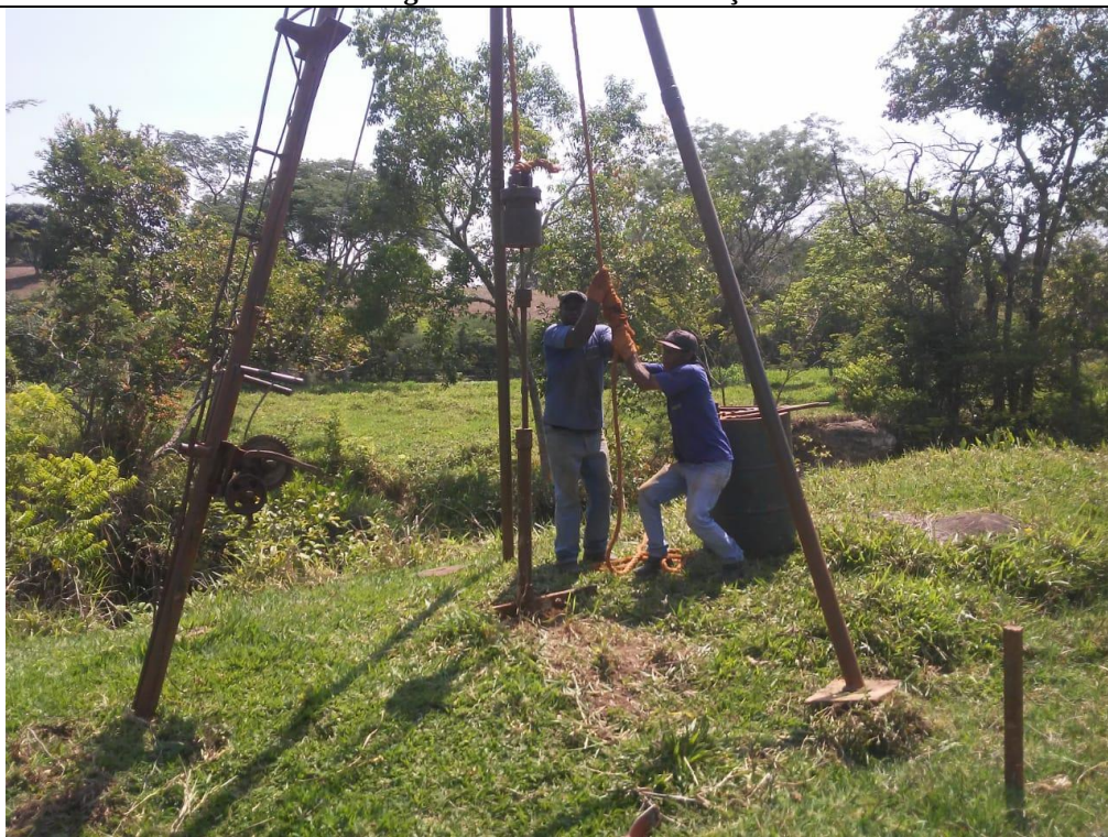
Imagem 14 - SP-201 em execução
