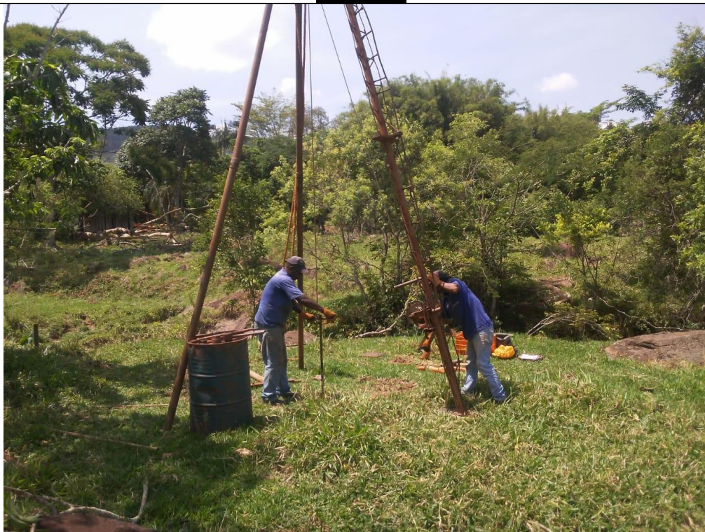
Imagem 13 - SP-200 em execução
