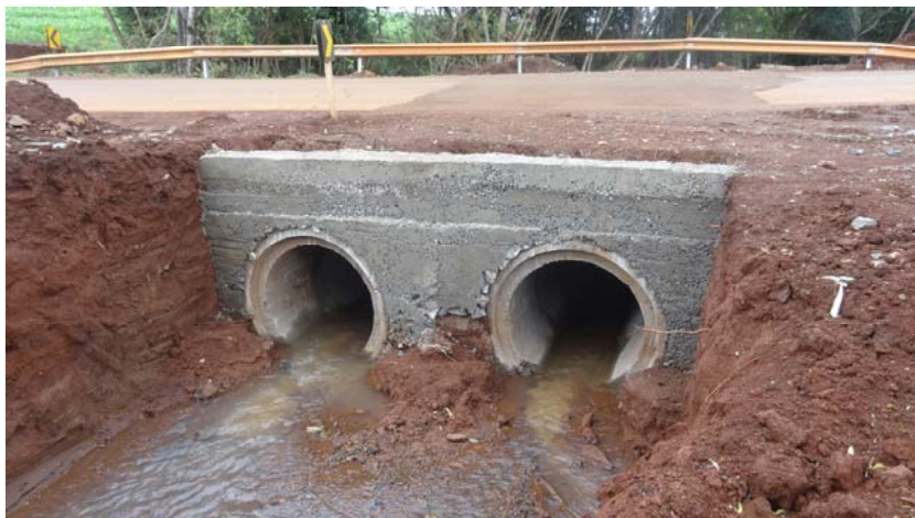
Figura 3.3-2 – Bueiros Implantados recentemente
