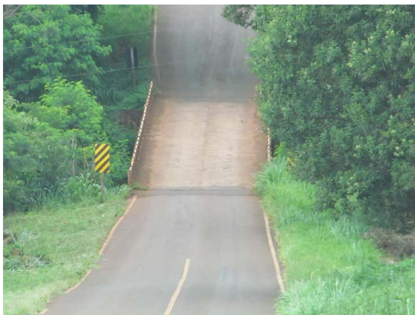
Figura 3.1-1 - Visão Geral da Ponte Sobre o Rio da Bulha
