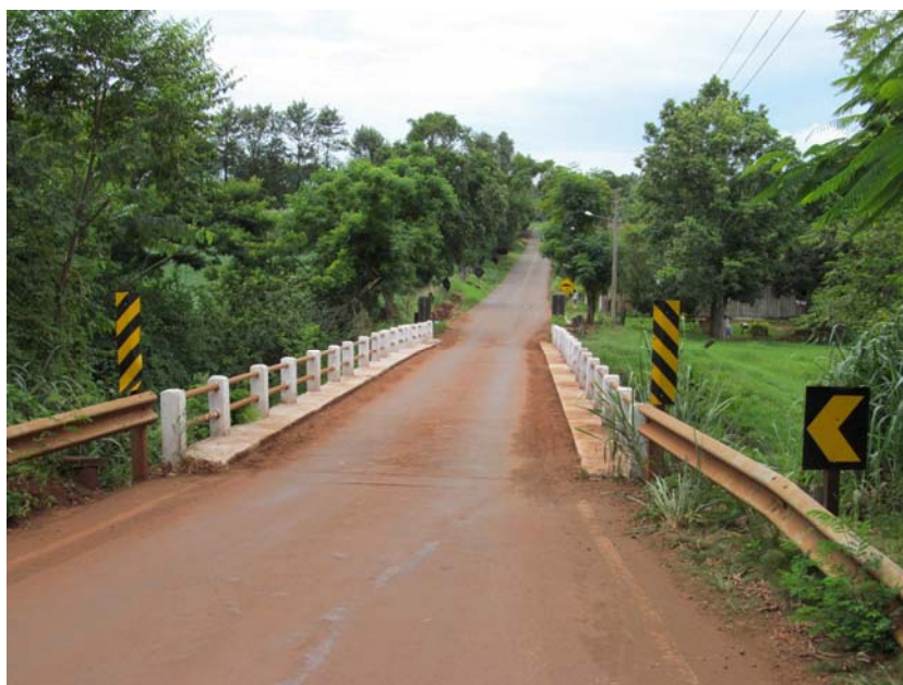
Figura 3.8-1 – Panorâmica da Ponte sobre o Rio Bananeira
