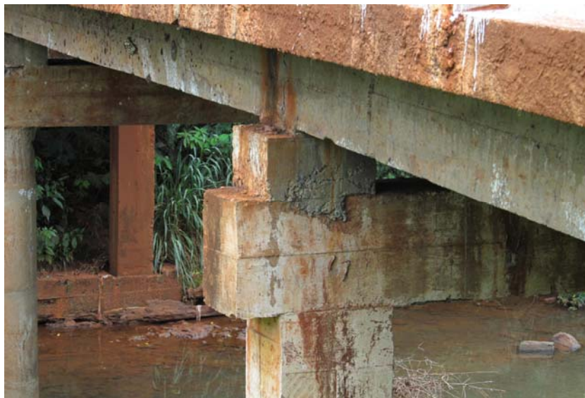
Figura 3.8-2 – Detalhe da Estrutura da Ponte Existente
