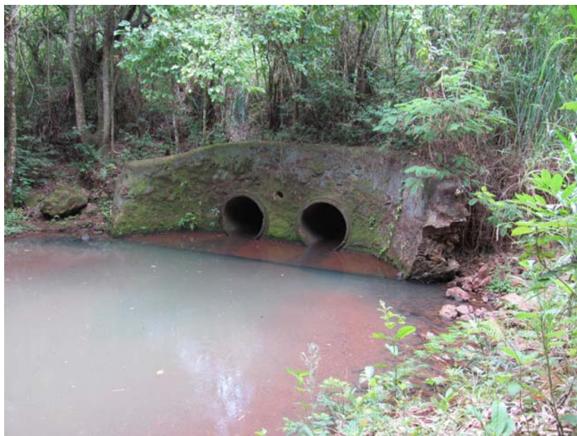
Figura 3.7-2 – Dispositivo de drenagem existente na Água do Manguairão
