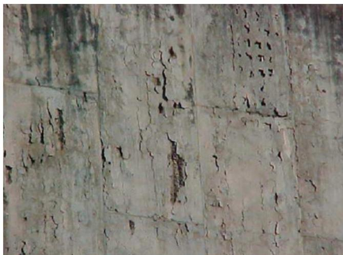
COBRIMENTO DEFICIENTE - DESPLACAMENTO
