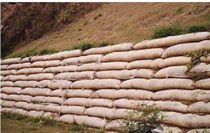
CONTENÇÃO COM SOLO-CIMENTO ENSACADO
