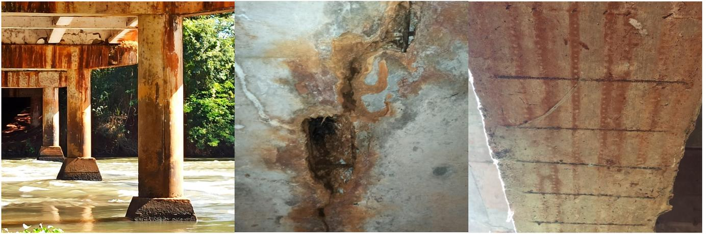
dos agregados e conseqüentemente a exposição da armadura da peça. Ocorre geralmente por efeitos de ataques químicos, fatores externos e/ou agravamento de um estado de Esfoliação prévio.
