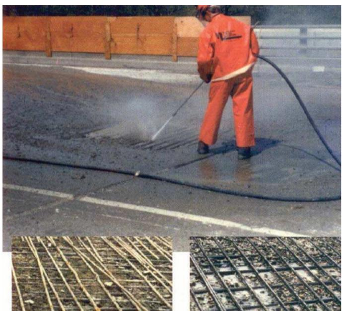
HIDRODEMOLIÇÃO COM EQUIPAMENTO MANUAL - NA PARTE INFERIOR DA FIGURA, À ESQUERDA AMOSTRA DE CORTE DO CONCRETO COM ROMPEDORES PNEUMÁTICOS; À DIREITA COM HIDRODEMOLIÇÃO
