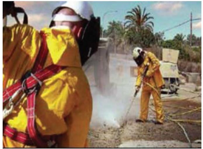
HIDRODEMOLIÇÃO C/ EQUIPAMENTO MANUAL
