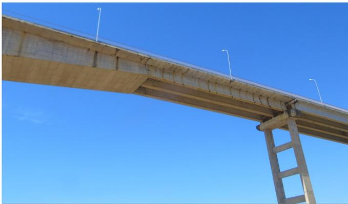
tudiniais e transversais, formando uma estrutura com seção celular e não maciça. Esse tipo de estrutura possui grande rigidez à torção, sendo indicada para pontes curvas, com pilares isolados ou com pequena altura para as vigas principais.
