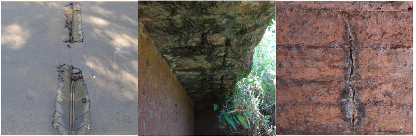
ção por expansão do material; entre outros. O surgimento de fissuras gera um desconforto ao usuário e também uma falha no sistema de proteção dos constituintes internos do concreto (principalmente armadura), um meio de entrada para fatores externos como água, CO<sub>2</sub>, fungos; que por sua vez dão início a um processo de degradação.
