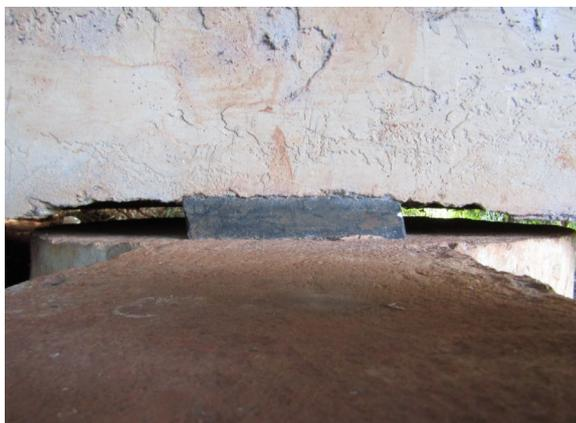
APARELHO DE APOIO ELASTOMÉRICO
