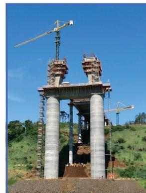
Para ancoragem dos cabos de estais será necessária a utilização de tubos forma feitos de aço que incorporam flexão e condições de vedação para as cordoalhas, estes tubos fazem parte do bloco de ancoragem. É necessário que cada tubo forma seja dimensionado e desenvolvido obedecendo ângulo, espessura e dimensão própria, tanto quanto o posicionamento correto de cada unidade. Hoje, estão estocados em canteiro de obras as 18 unidades dos tubos de aço que serão ancorados na retaguarda brasileira.
