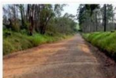
— Intervenção consiste na pavimentação de trecho de três quilômetros de extensão. Foto: Divulgação
