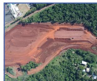
Na área da Aduana Brasil-Argentina e Brasil-Paraguai os serviços de escavação, carga, transporte, descarga, espalhamento e compactação de aterro continuam sendo realizados, bem como submetidos a ensaios de compactação de camada para liberação de serviço.
