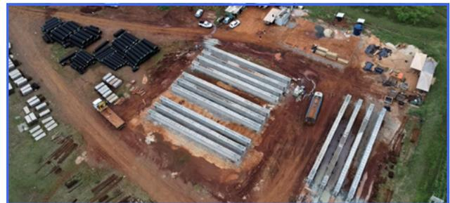
No Viaduto de acesso à Ponte Tancredo Neves, também foi dada continuidade na montagem das formas do guarda-rodas sobre o tabuleiro, atingindo um percentual de 94,08% já executado. No Viaduto da BR-469, foram realizadas as protensões das vigas pré-moldadas para posterior posicionamento sobre a mesoestrutura, totalizando neste período 59,42% da execução.
