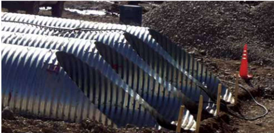
Figura 12 – Extremidade do bueiro em tubo metálico
