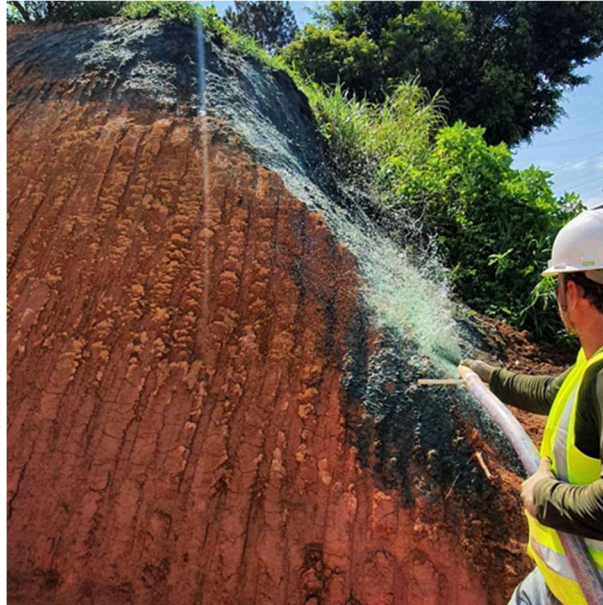
Figura 4 – Hidrossemeadura
