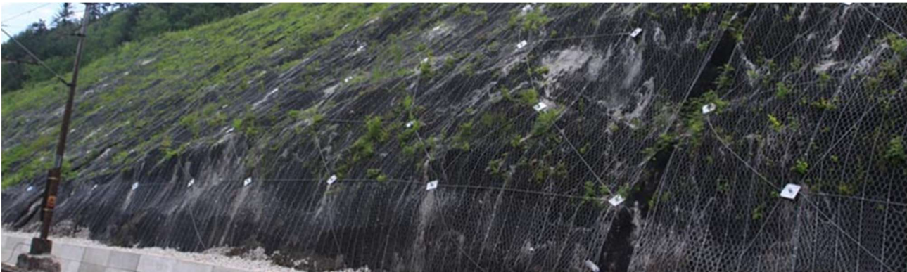
Figura 9 – Talude protegido com tela de aço
