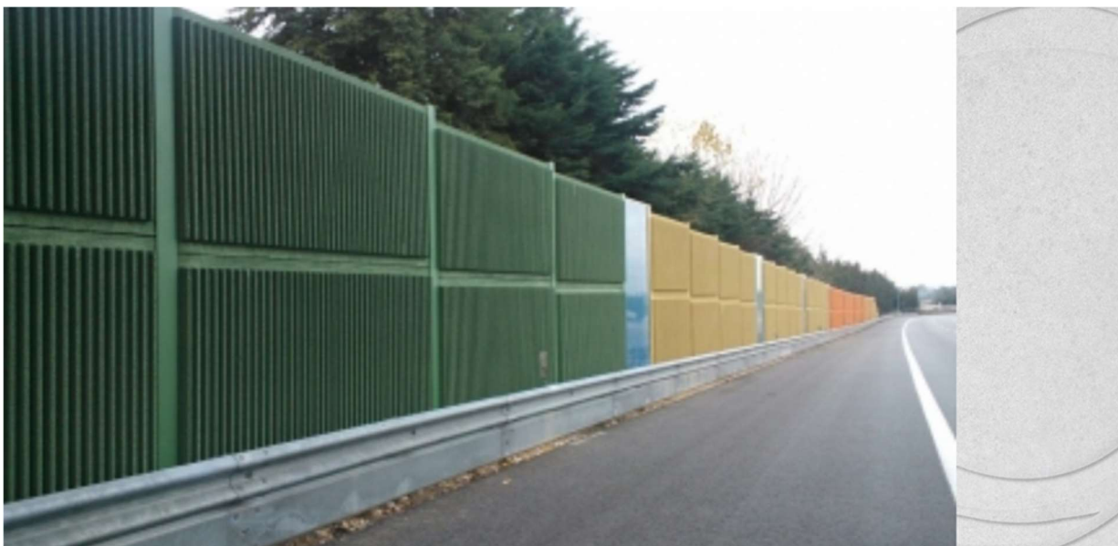
Figura 16 – Aplicação de barreiras acústicas
