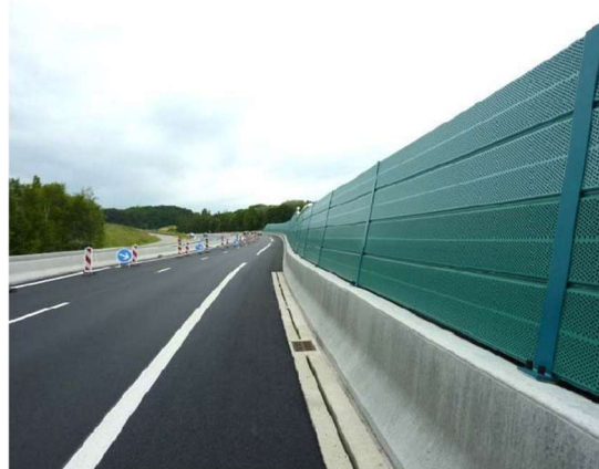
Figura 15 – Barreira acústica em rodovia
