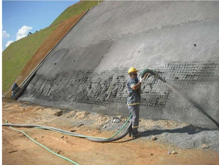
Figura 8 – Aplicação de concreto projetado
