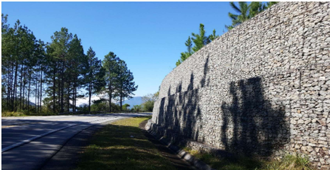
Figura 10 – Muro de gabião
