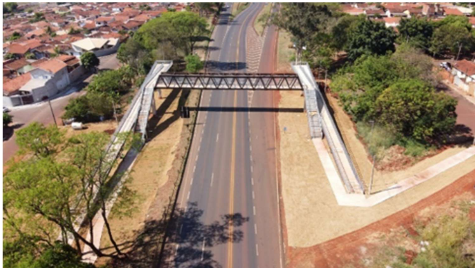
Figura 63 – Exemplo de passarela de pedestres
