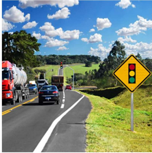
Figura 79 – Sinalização de advertência indicando a presença de semáforo
