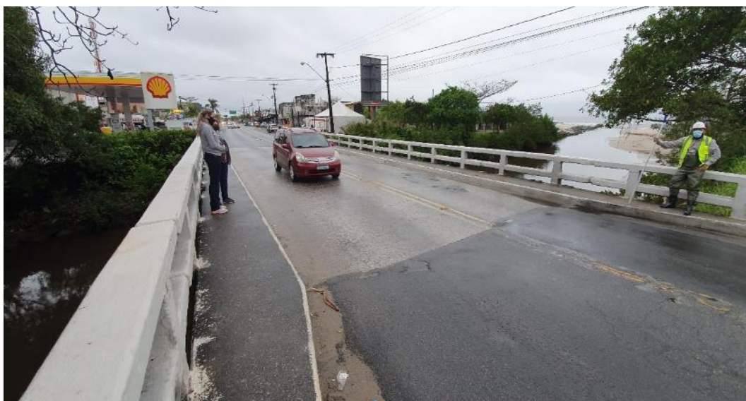
FIGURA 4.4-2 - VISÃO GERAL DA OBRA SOBRE O RIO MATINHOS
