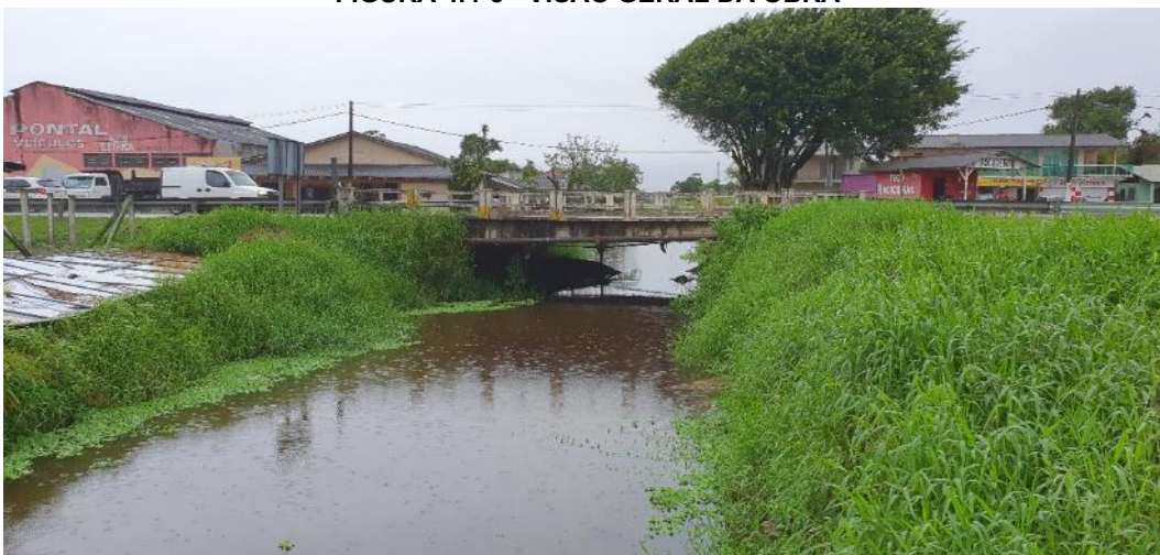
FIGURA 4.4-5 - VISÃO GERAL DA OBRA
