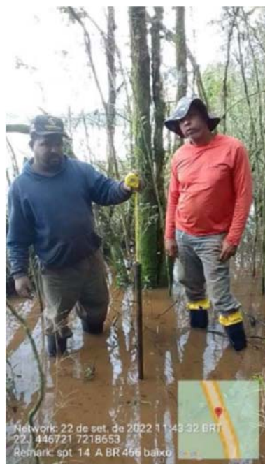
Furo SPT B-14 – ambiente brejoso com ocorrência de camada delgada de material mole (turfa) UTM 446721 / 7218653
