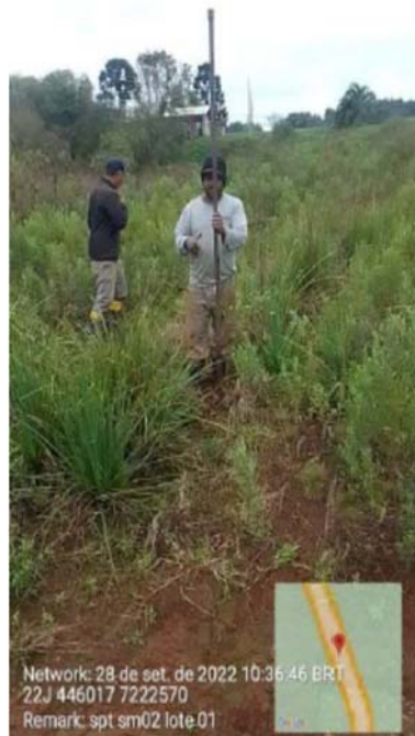
Furo SPT SM-02 – impenetrável à cavadeira durante abertura do furo para instalação do revestimento UTM 446017 / 7222570
