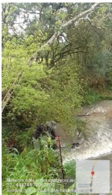
Furo SPT B-20 – rocha aflorante na vala de escoamento junto à boca do bueiro existente UTM 444744 / 7208770
