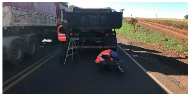
Levantamentos deflectométricos com medição de deflexão inicial com apoio de viga Benkelman
