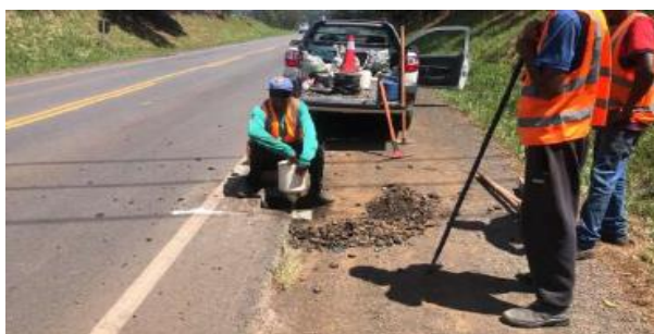
Ensaio de densidade in-situ da base em cava aberta no bordo da pista de rolamento
