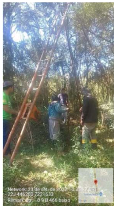
Furo SPT B-09 – ambiente brejoso com ocorrência de camada delgada de material mole (argila) UTM 446250 / 7221633
