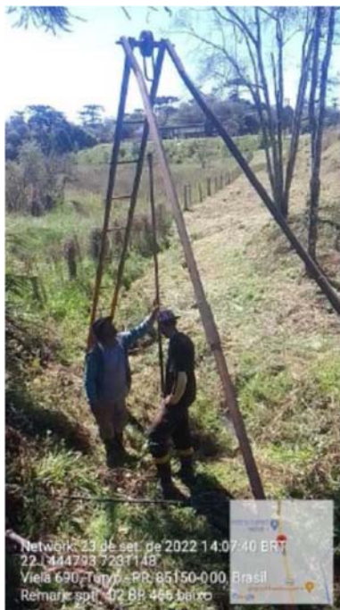
Furo SPT B-02 – material de saia de aterro sobre camada delgada de solo mole UTM 444793 / 7231148
