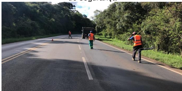
Deslocamento operacional durante levantamento deflectométrico
