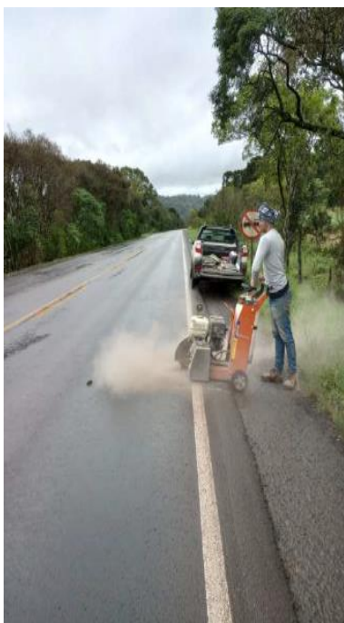
Recorte do pavimento com serra clipper sobre a trilha de rodas para abertura de cava
