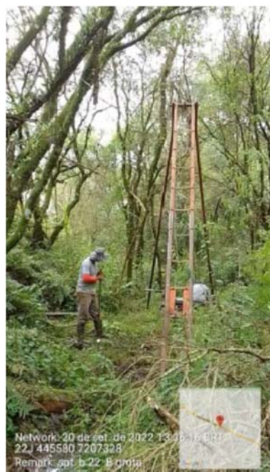
Furo SPT B-22 – ambiente brejoso com ocorrência de camada delgada de material mole (turfa) UTM 445580 / 7207328
