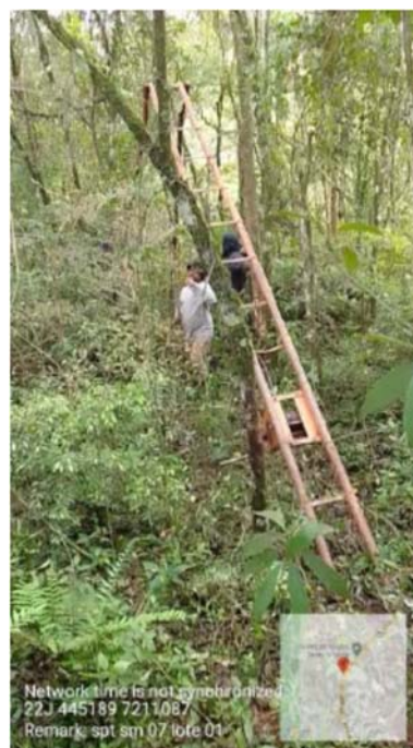
Furo SPT SM-08 – ambiente brejoso com ocorrência de camada espessa de material mole (turfa e argila) UTM 445189 / 7211089
