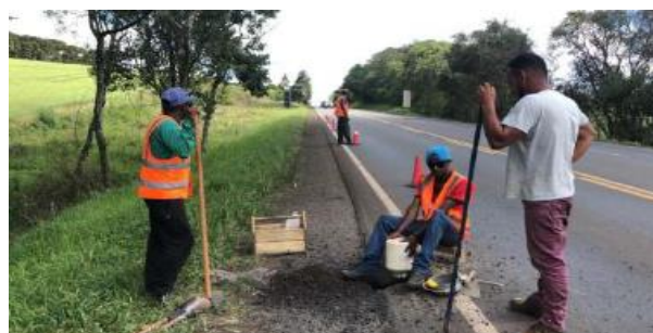
Equipe de apoio e sinalização de segurança durante a realização de ensaio de densidade in-situ
