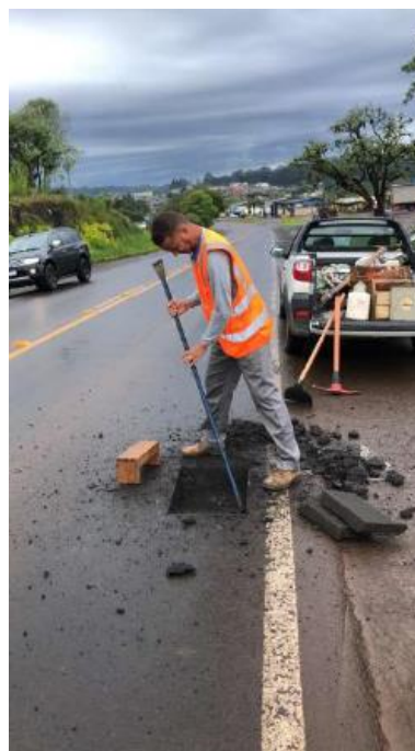
Remoção do revestimento após recorte para exposição da camada de base
