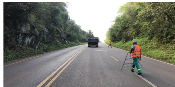
Deslocamento operacional durante levantamento deflectométrico
