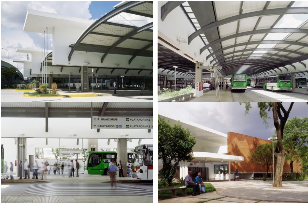
Figura 22 – Terminal da Lapa (Núcleo de Arquitetura)
