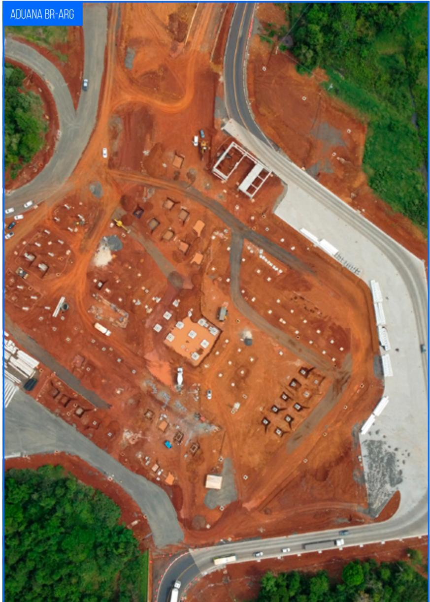
Nos blocos que já foram finalizados ocorreu o içamento de 38 pilares com cerca de 8 metros de altura, atingindo 38,77% da execução da mesoestrutura da cobertura. Além disso, com a conclusão das fundações do edifício administrativo, também foi possível começar o içamento dos pilares pré-moldados.
