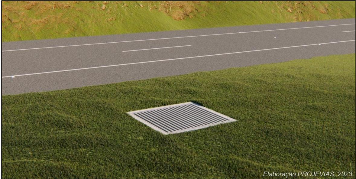
Dispositivos de drenagem que estão localizados fora da rota normal dos veículos, mas podem ser atingidos por veículos desgovernados e não podem ser adequadamente aprimorados, devem ser identificados de maneira a torná-los facilmente visíveis e reconhecíveis. Embora isso não diminua a gravidade de um sinistro de trânsito, reduzirá a probabilidade de que ocorra. Nessas situações, deve-se considerar a implementação de dispositivos de proteção, como defensas.
