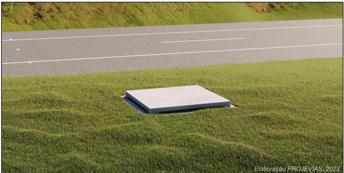
A figura 4 apresenta o exemplo de uma estrutura deficiente: um ralo com tampa exposta e altura suficiente para constituir obstáculo ao veículo. Abaixo, a figura 5 apresenta uma situação mais adequada: um ralo com fechamento transpassável que permite aos veículos que venham a cruzá-lo possam recuperar a trajetória sem obstruções ou maiores danos.
