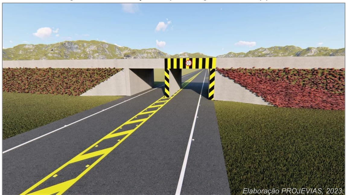
Figura 110 – Utilização em pilar e viga de viaduto (1).
