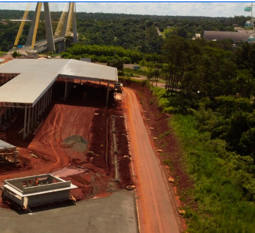
Simultaneamente, as demais estruturas de apoio seguem avançando com a finalização das estruturas de concreto e início das alvenarias de fechamento.
