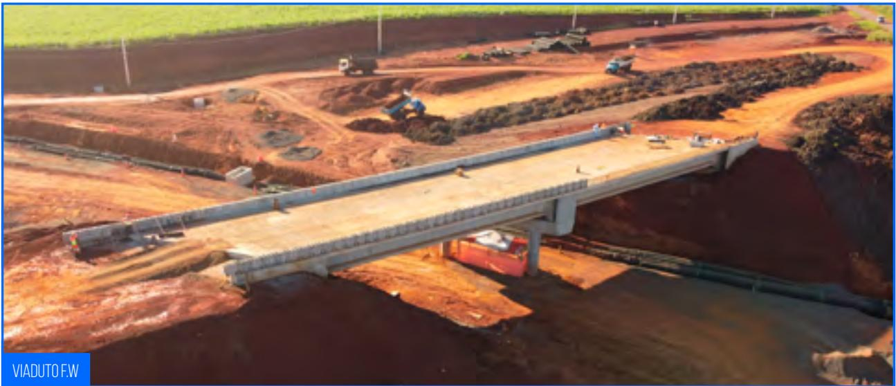
A implantação das defensas metálicas teve continuidade, conforme o planejamento estabelecido. No viaduto da Felipe Wandscheer, foi realizada a concretagem das barreiras rígidas, reforçando os dispositivos de contenção.
