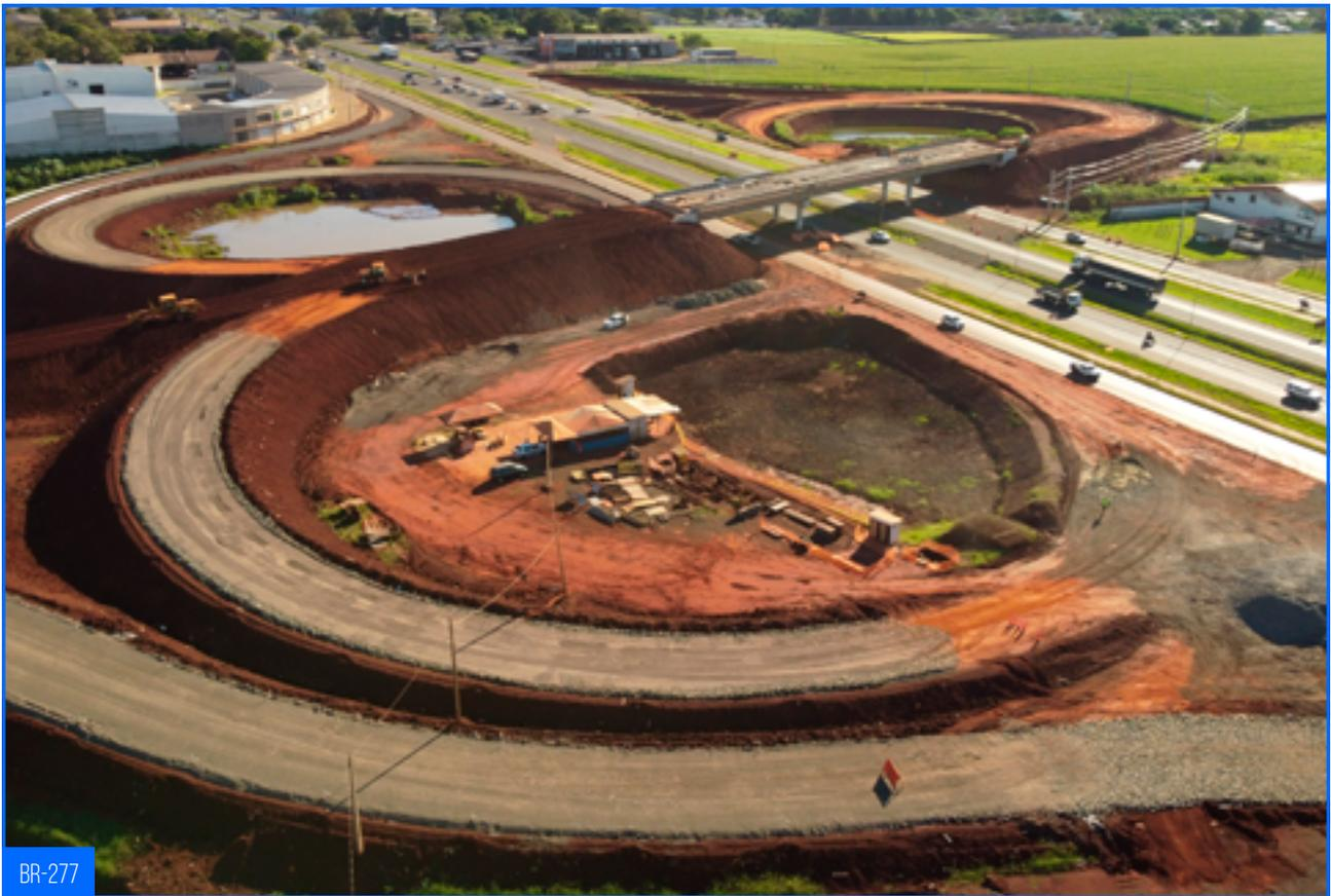
No viaduto da BR-277, foram concretadas cerca de 75% dos guarda rodas, a próxima etapa será a execução das lajes de transição, aproximando a estrutura de sua finalização.
