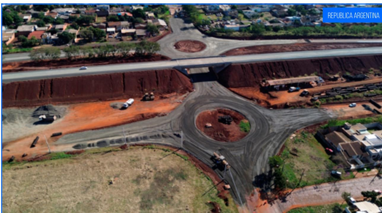
Proseguimos com evolução na execução de revestimento asfáltico na Linha Geral e nas alças da interseção com Br-277, com a aplicação de 3.872 toneladas de CBUQ (Concreto Betuminoso Usinado a Quente), atingindo 75,4% de conclusão do montante previsto para a obra.
