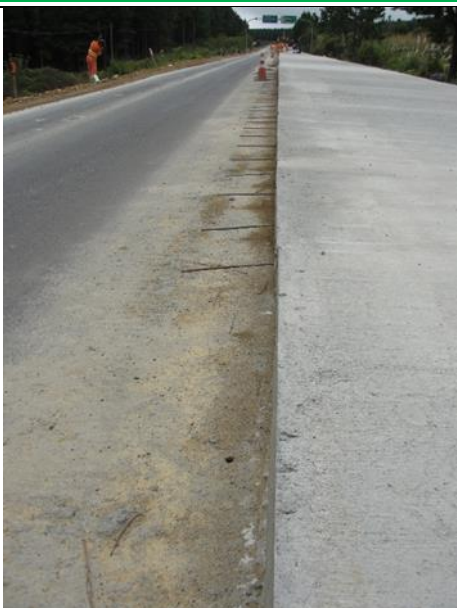
Fotografia 3 – Pista da direita concretada – tráfego pelo sistema PARE / SIGA na faixa da esquerda
