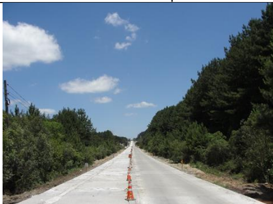
Fotografia 7 – Detalhe de execução do pavimento de concreto – duas faixas concretadas – uma faixa isolada em processo de cura do concreto
