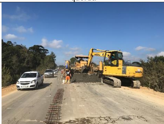
Fotografia 5 – Detalhe de execução do pavimento de concreto – tráfego da rodovia na faixa não concretada e detalhe do posicionamento da escavadeira na frente da pavimentadora
