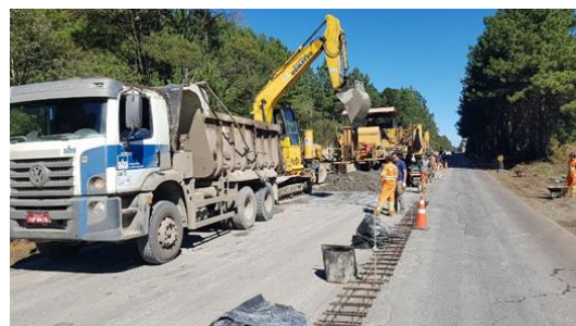
Fotografia 6 – Detalhe de execução do pavimento de concreto – caminhão basculante + escavadeira hidráulica + pavimentadora
